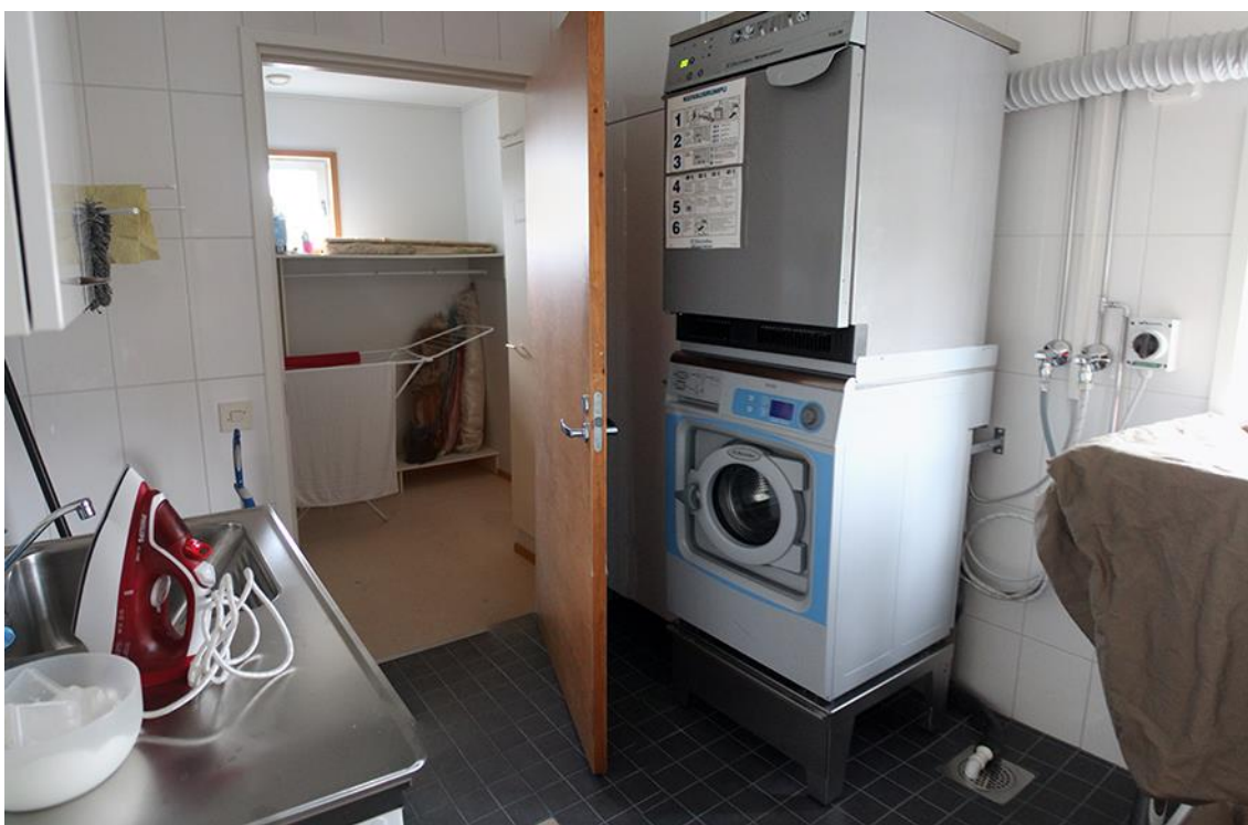
Ryhmäkotien varustukseen kuuluu kodinhoitotila, jossa on muun muassa teollisuuslaatua olevat pyykin pesu- ja kuivauskoneet. Esimerkkikuva on Järvenpäästä.
